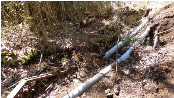
迂回した箇所は植生損傷 左:事後4月28日)⑥
