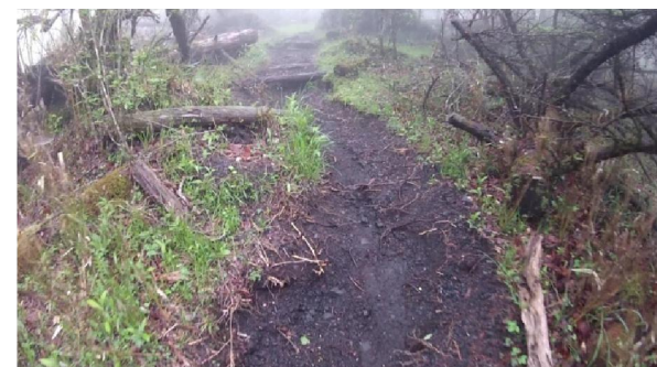
世界遺産部分の登山道。事後の降雨により表層土壌が流され、雨水経路化してきた歩行区間。今後の降水によりさらに土壌侵食が懸念される。(左:事後 4 月 28 日、右:雨後 5 月 31 日)⑫
